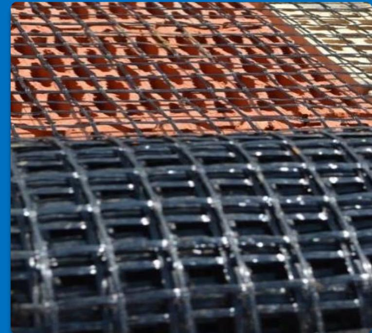
Армування горизонтальних швів кладки стін, що зводяться в сейсмонезбезпечних регіонах, з метою підвищення несучої здатності кладки.
